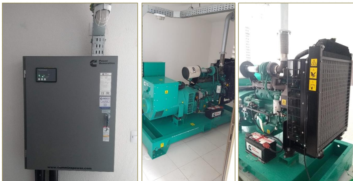
Imagens: quadro de controle e gerador de energia.
