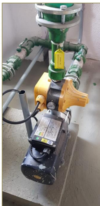
Imagens: quadro de comando das bombas de pressurização e bombas de pressurização 1 e 2 das coberturas.
