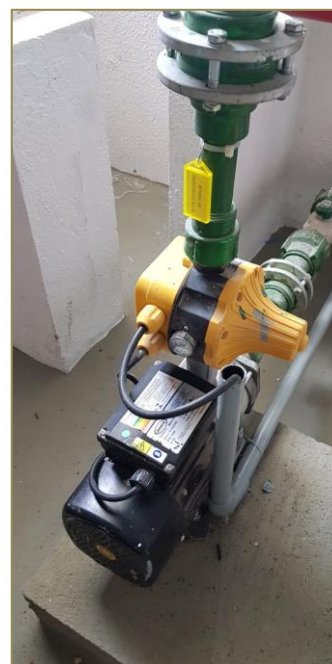
Imagens: quadro de comando das bombas de pressurização e bombas de pressurização 1 e 2 das coberturas.
