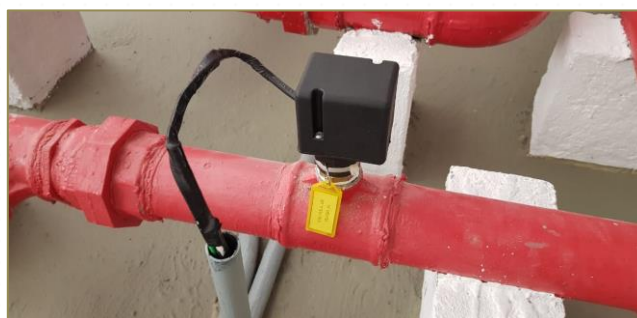
Imagem: válvula de fluxo 1 Barrilete Superior.
