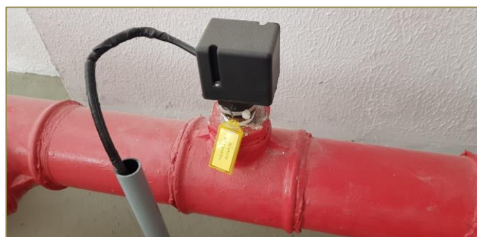
Imagem: válvula de fluxo 02 Barrilete Superior.
