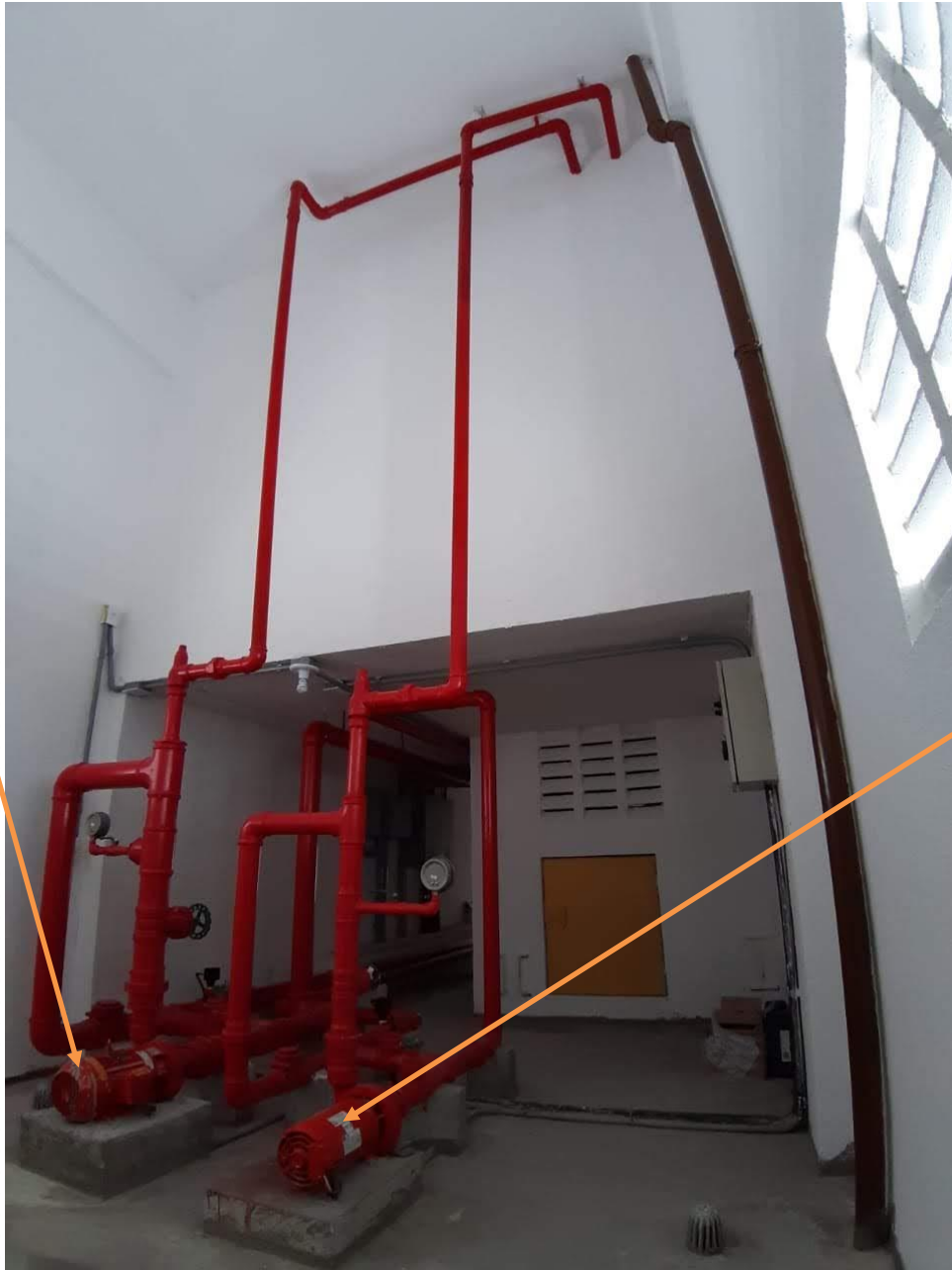
Imagem: sistema incêndio Barrilete Superior.
