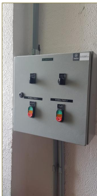
Imagens: quadro de comando das bombas de pressurização e bombas de pressurização 1 e 2 das coberturas.
