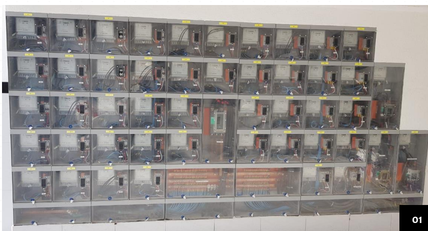
Imagem 01: Centro de medição localizado no Pilotis.
