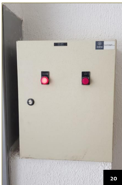
Imagem 20: Quadro de bombas de incêndio devidamente identificado.
