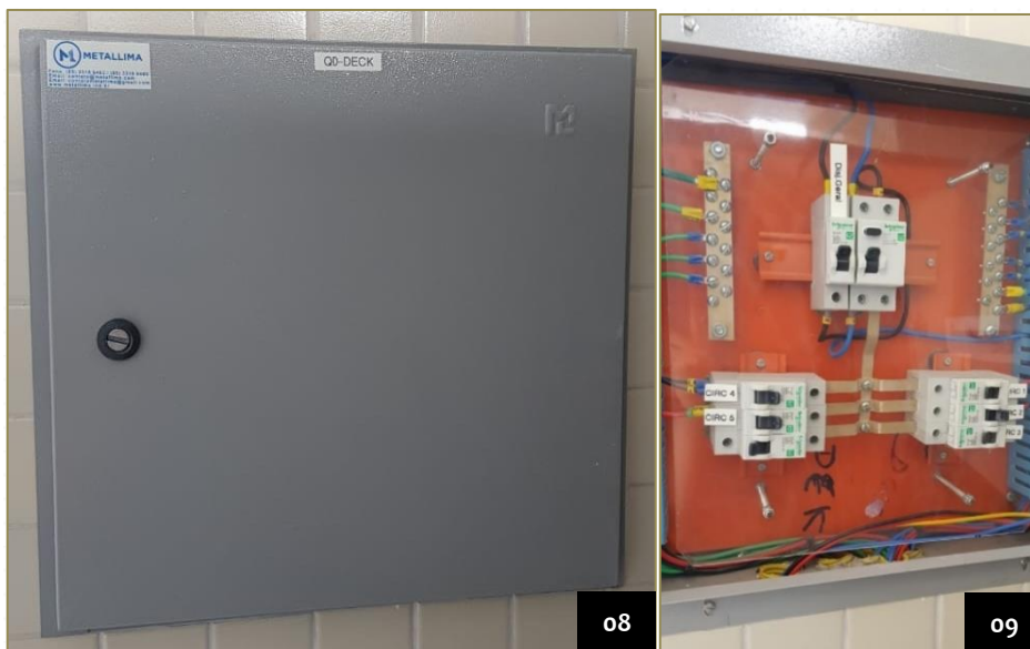
Imagens 08 e 09: Quadro de Distribuição do Deck devidamente identificado.
