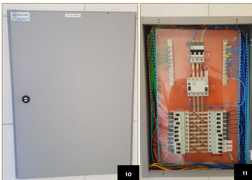
Imagens 10 e 11: Quadro de Distribuição da Guarita devidamente identificado.
