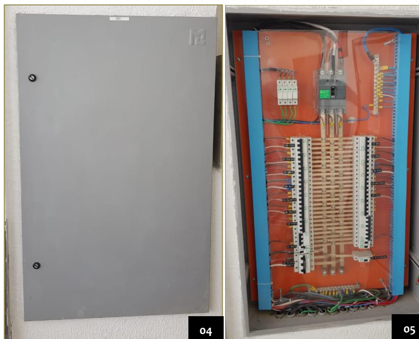
Imagens 04 e 05: Quadro de Distribuição do Condomínio devidamente identificado.
