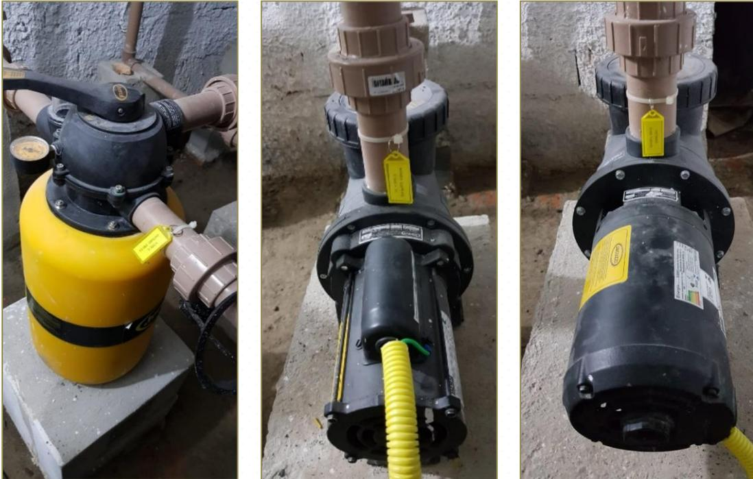
Imagens: filtro, bomba e bomba de bicos do espelho d'água.
