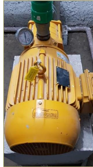
**Imagens:** bombas de recalque 1 e 2 (Alimentam as caixas d'água).
